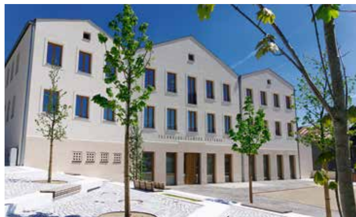
Gebäude Technologie Campus Grafenau
